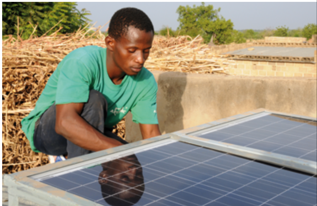
Un technicien de BETA installe un kit.
