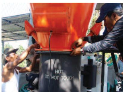
À Sambour, l'installation des équipements s'est faite avec l'appui de la communauté rurale, avec le déballage des composants, le positionnement des filtres et l'assemblage du réacteur.
