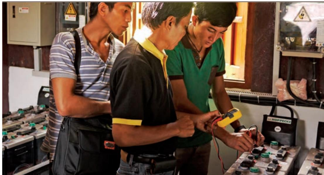
Le banc de batteries requiert un contrôle régulier pour s'assurer de sa longévité.
