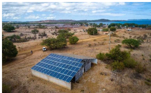
Photo 1: Centrale photovoltaïque d'Ampasindava -- ANKA Madagascar
