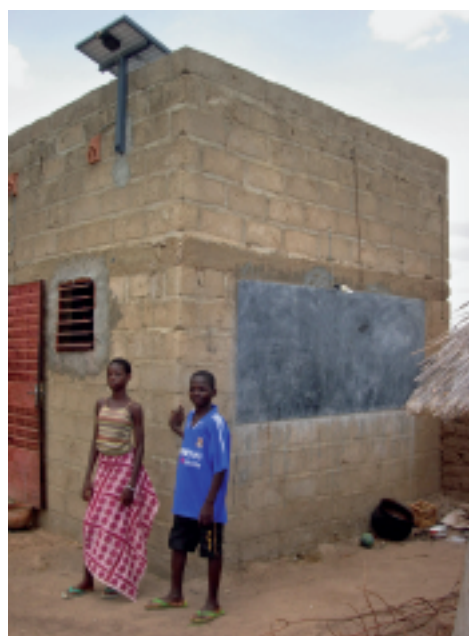
L'énergie solaire : une bonne option pour électrifier les dispensaires, les écoles, les maisons individuelles ou les petits ateliers (ici au Burkina Faso).
