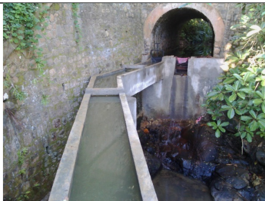
Figure 5 : Canal d'aménagé de la picocentrale hydroélectrique de Sahisanaka (Gret)
