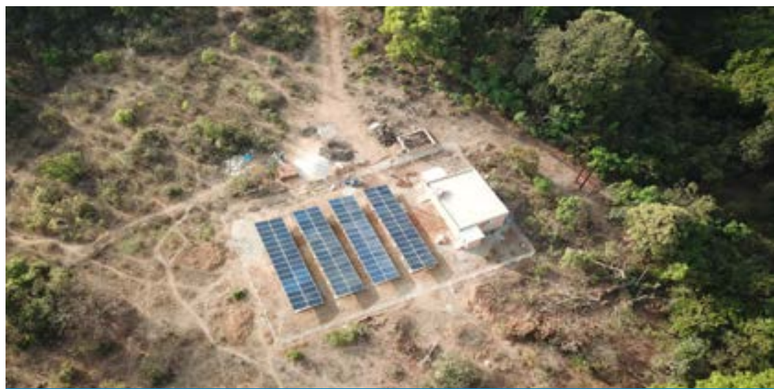
Vue aérienne de l'une de trois centrales solaires installées en Guinée
