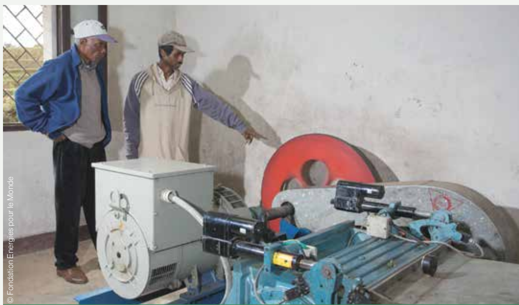
Microcentrale hydraulique d'Antetetzambato (Madagascar) - 42 kW.
