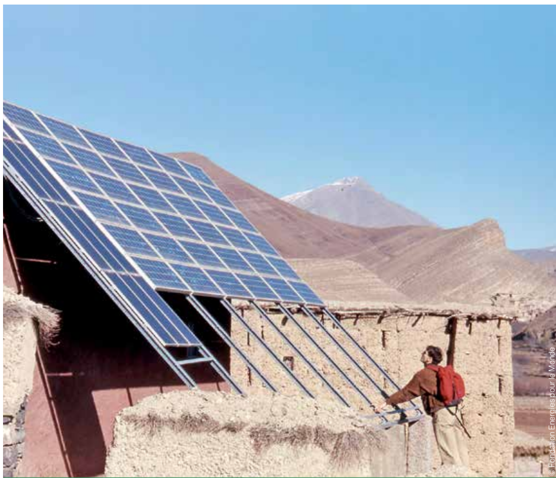
Le Programme Pilote d'Electrification Rurale au Maroc, pionnier de l'ERD.
