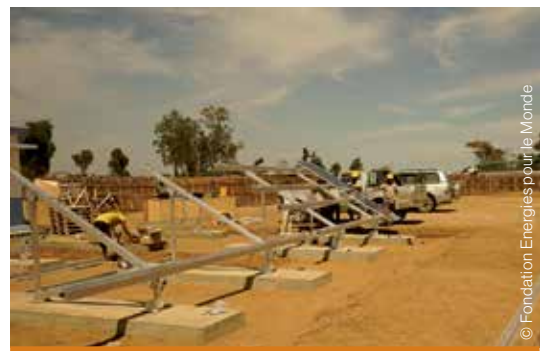
Installation d'un miniréseau à Madagascar.
