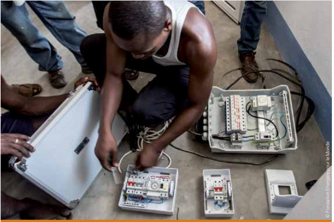
Préparation des interfaces pour le raccordement des usagers
