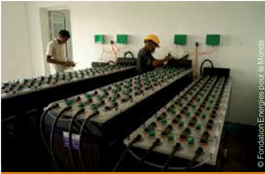
Les batteries sont vérifiées quotidiennement par l'équipe exploitante de la centrale
