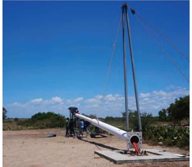
*Maintenance complète annuelle des deux éoliennes de 6 kW installées à Ambondro par l'équipe technique de l'ASA et sous la supervision d'un opérateur spécialisé.*
