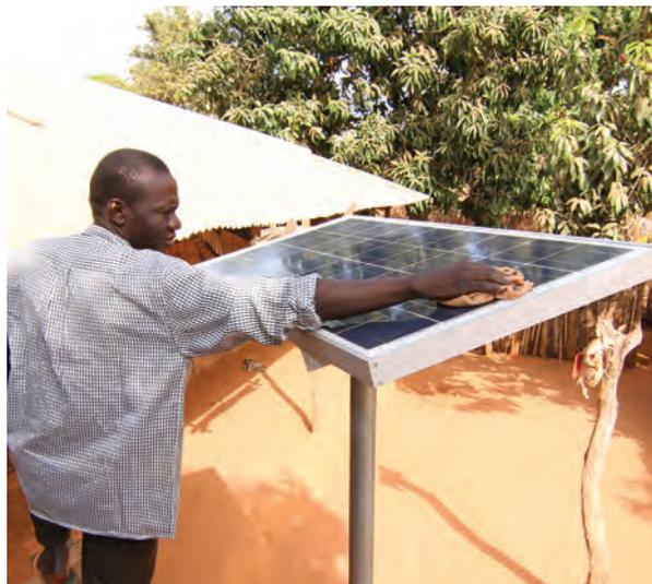
Vérification du bon état et de la propreté du module d'une installation à Ouonck par l'un des 5 techniciens prestataires du CGESO.
