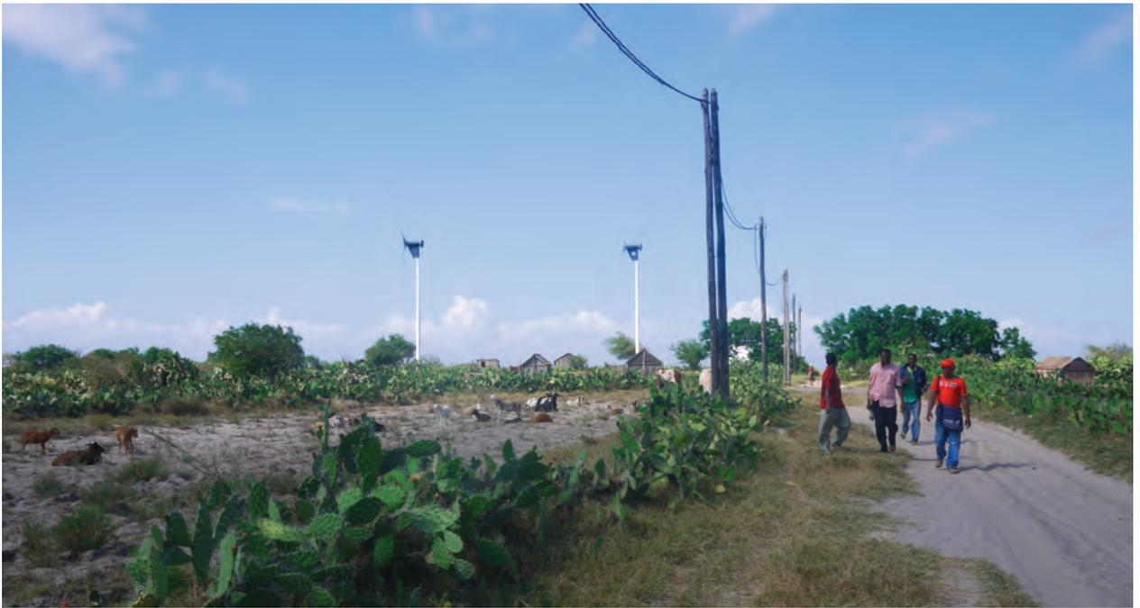
*Pour s'assurer de la capacité réelle des 2 éoliennes de 6 kW couplées à un réseau de distribution à Ambondro, les raccordements d'abonnés ont été progressifs. Aujourd'hui, 90 ménages, infrastructures de service public et entrepreneurs bénéficient des services de l'électricité.*
