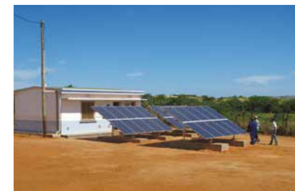
La centrale de Tanandava de 7,5 kWc.
