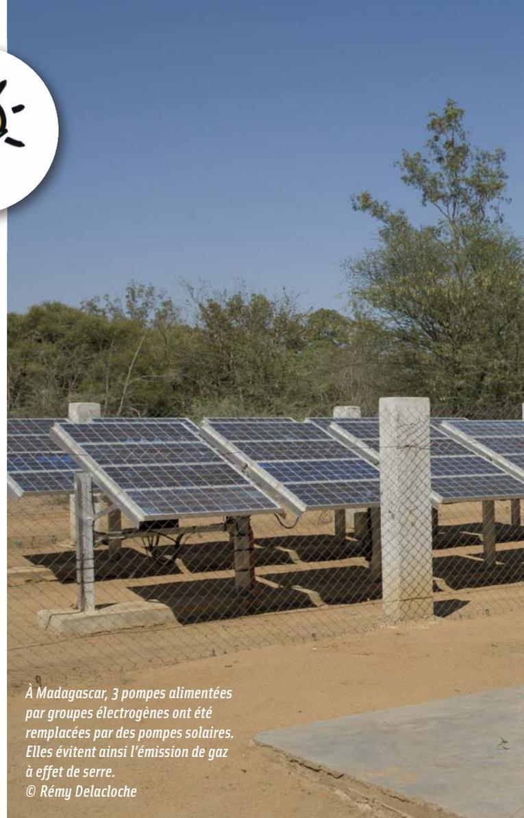
À Madagascar, 3 pompes alimentées par groupes électrogènes ont été remplacées par des pompes solaires. Elles évitent ainsi l'émission de gaz à effet de serre.
