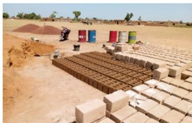
*Briques de terre séchées devant servir à la construction des locaux techniques des centrales photovoltaïques.*
